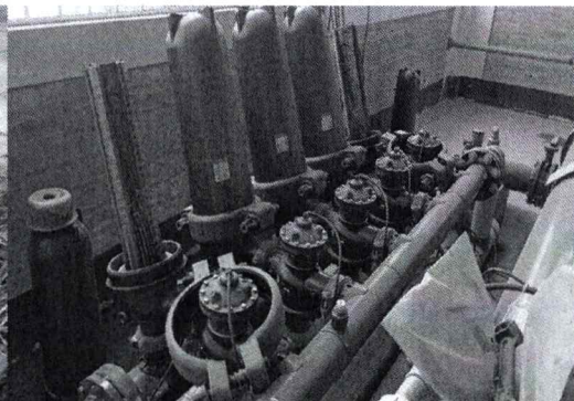
Imagen 2: Mantenimiento a los filtros de riego.
